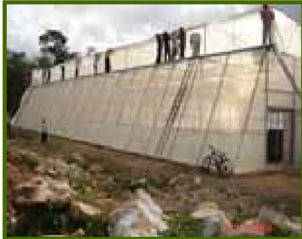
Construcción de Invernadero
