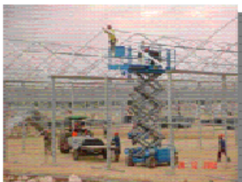
Armado de estructuras
