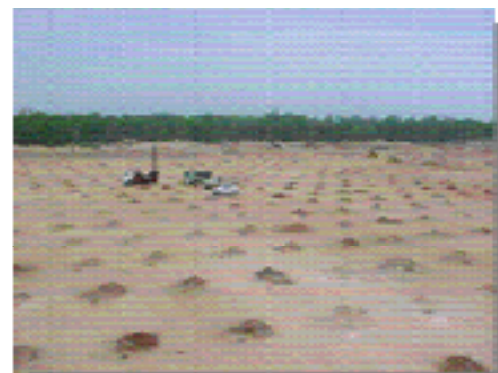
Perforación de cimentación
