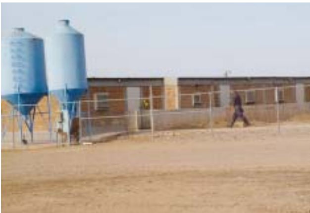
Pasillos de comunicación dentro de la granja
