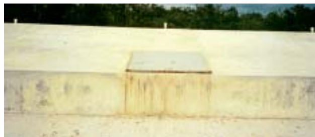
Pits de concreto
